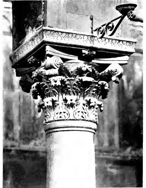
D. In Nave
